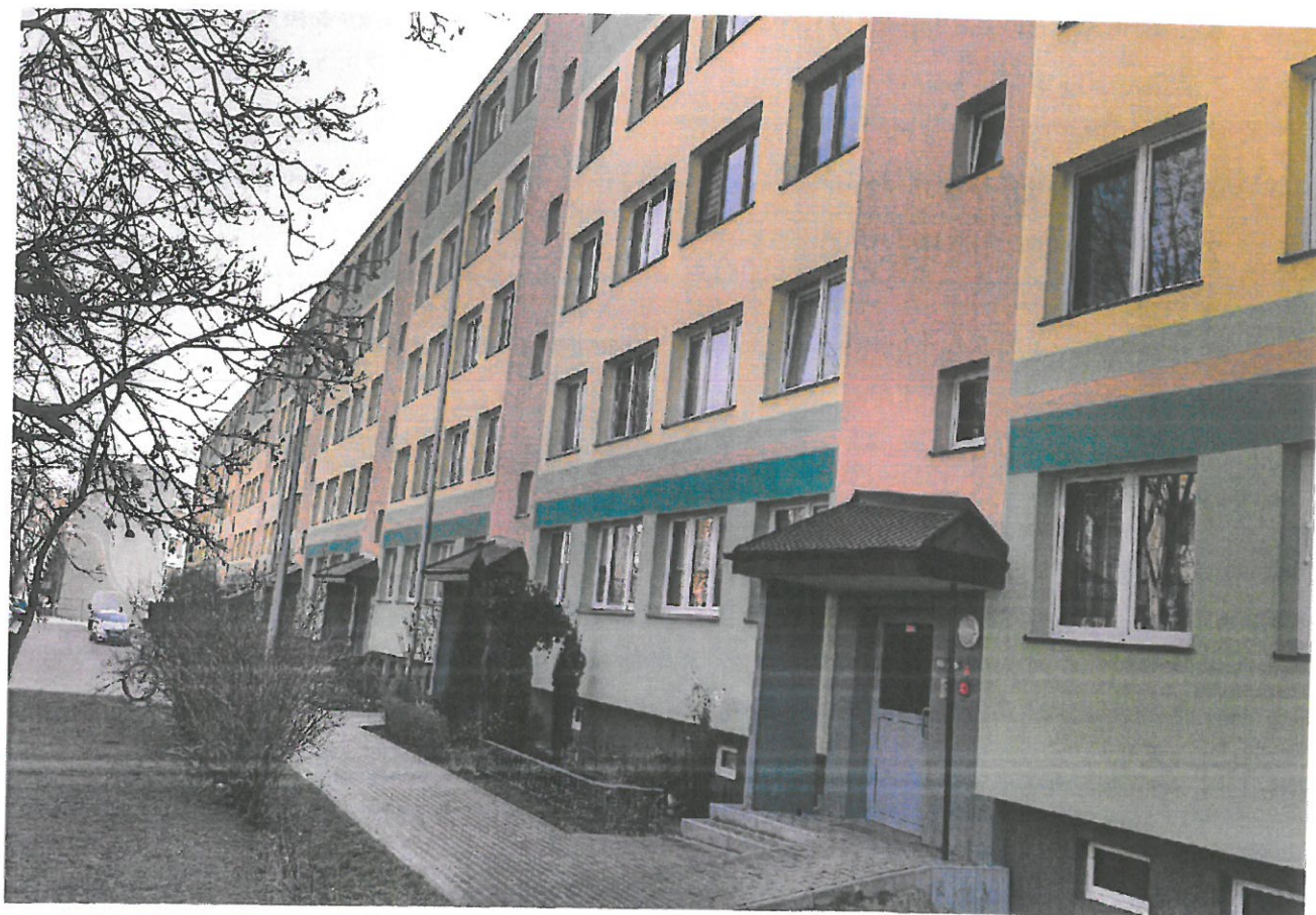
Zdjęcia budynków mieszkalnych po renowacji elewacji – Grunwaldzka 12b i Chrobrego 8.
